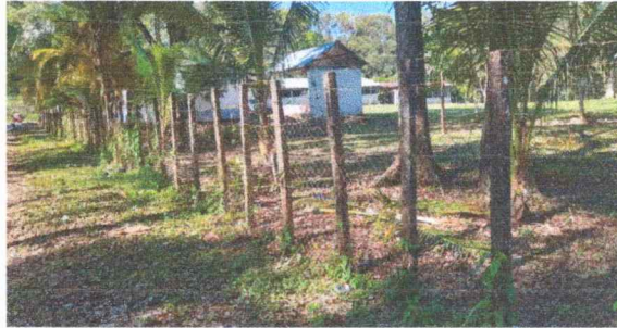
Foto 2: se observa el deterioro de la malla
