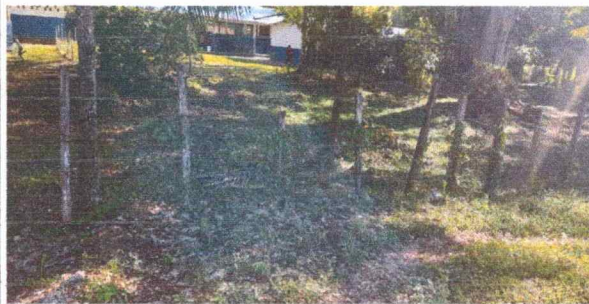
Foto 4: se observa el deterioro del cercado
