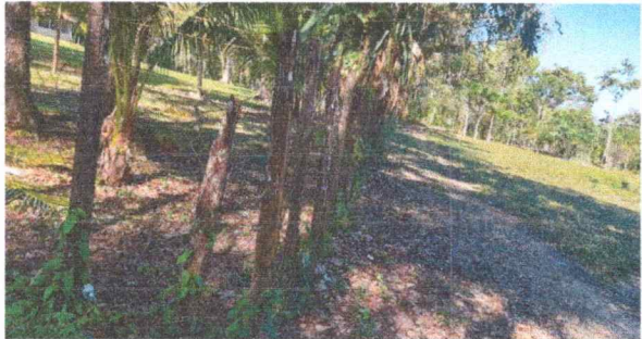
Foto 1: se observa el deterioro del cerco perimetral
